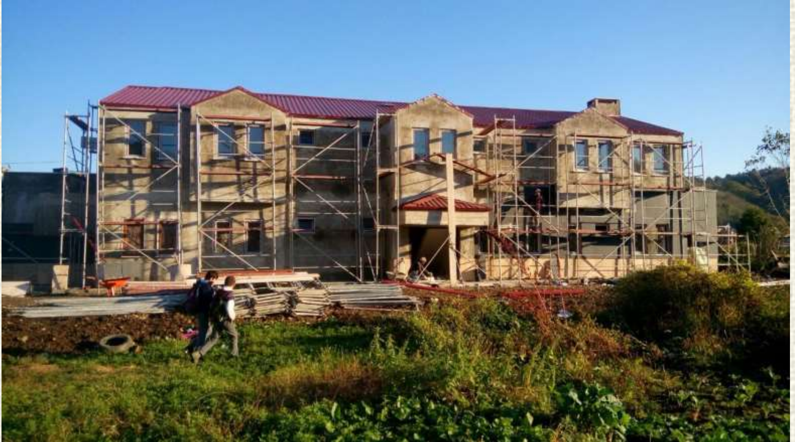
Araklı Orman İşletme Şefliği İdari Binası İnşaatı Çalışmaları
