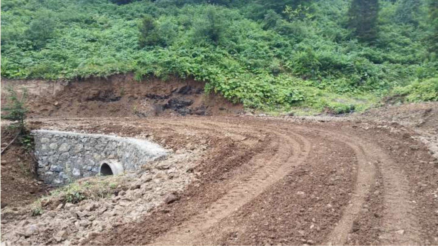
Maçka Orman İşletme Şefliği 167 kod nolu yolda sanat yapısı çalışması
