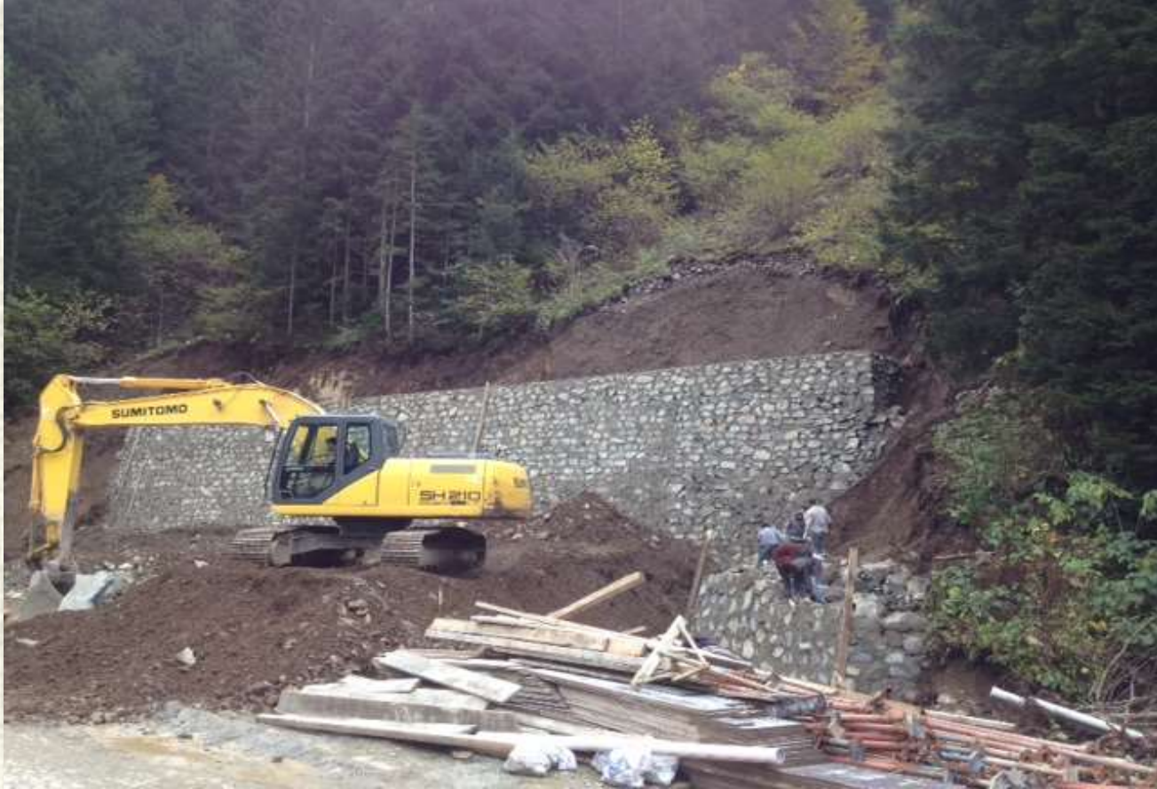
Uzungöl Toplu Koruma Ekip Binası İnşaatı Çalışmaları
