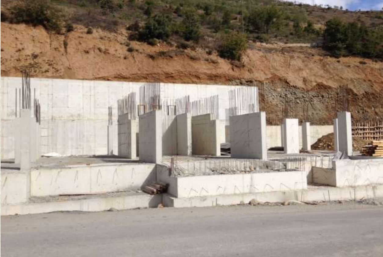
Kürtün Toplu Koruma Ekip Binası İnşaatı Çalışmaları
