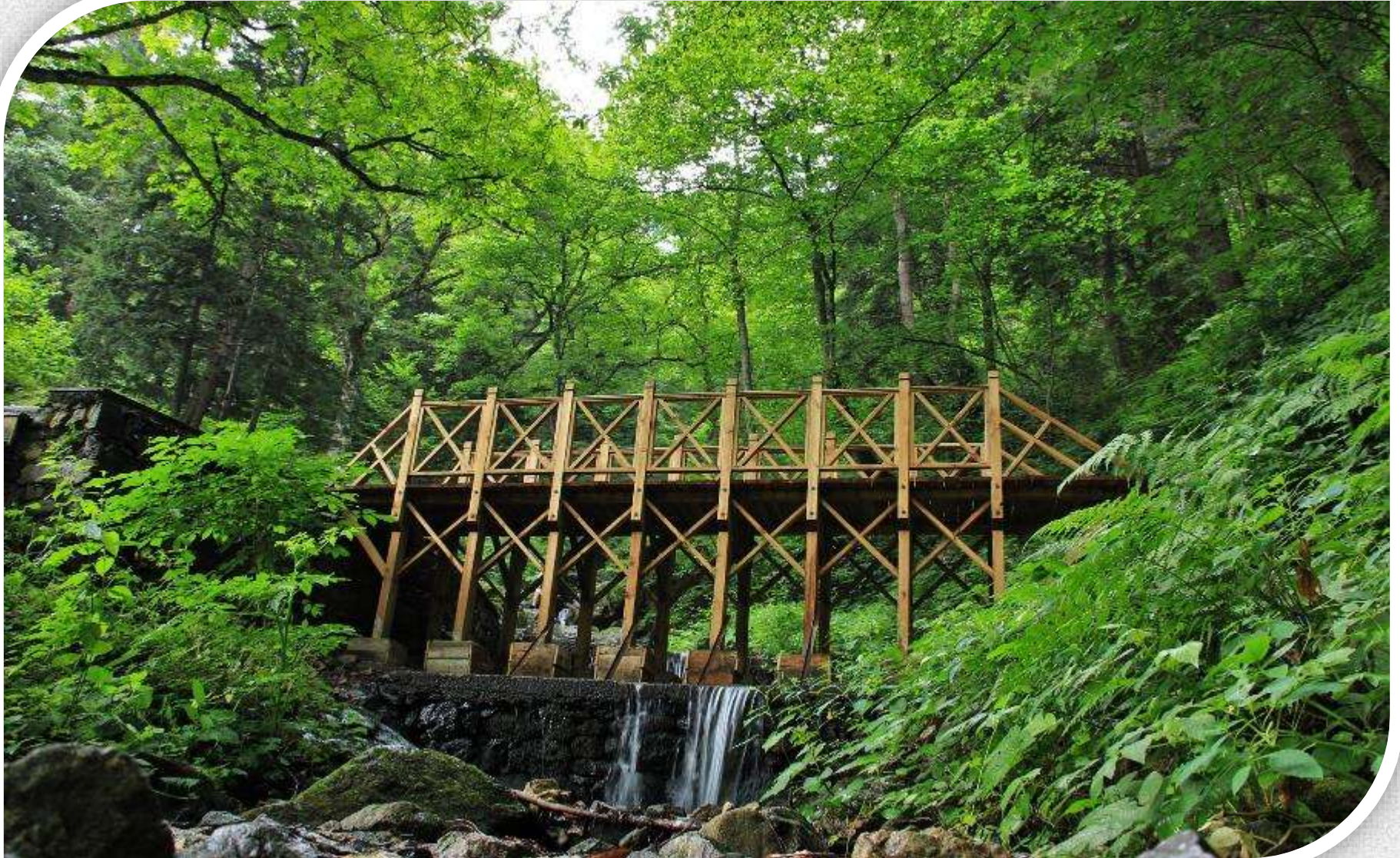
2 Adet Ahşap Köprü
