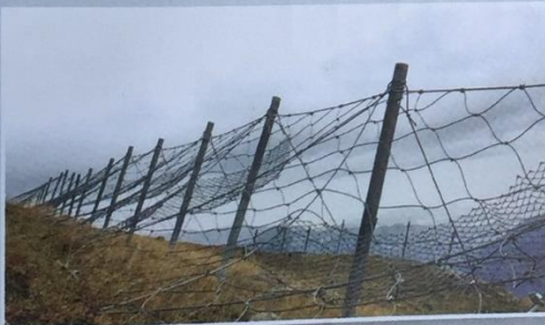
Trabzon/Uzungöl Çığ Kontrolü Uygulama Projesi sahasından görüntüler
