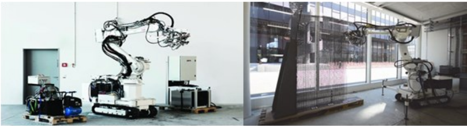
Şekil 7: Hareketli Robot Kolun (Manipülatör) Şantiyede Kullanımı (Hack, 2018)
