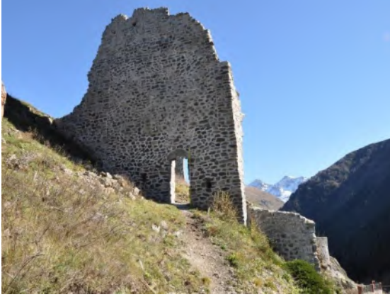
Res. 56. Kuzey Cephesi Dış Tarafı
