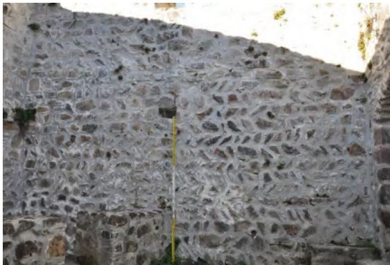
Res. 69, 70. Zir Kale ve Kal-i Bala Balık Sırtı Duvar Tekniği
