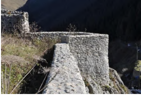
Res. 53. Batı Sur Duvarı ve Burçları
