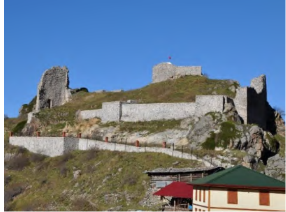
Res. 50. Batı Sur Duvarı
