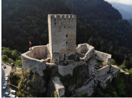
Res. 6. Zir Kale Güneydoğu Cephe
