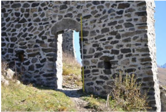
Res. 58. Giriş Kapısı Dış Tarafı
