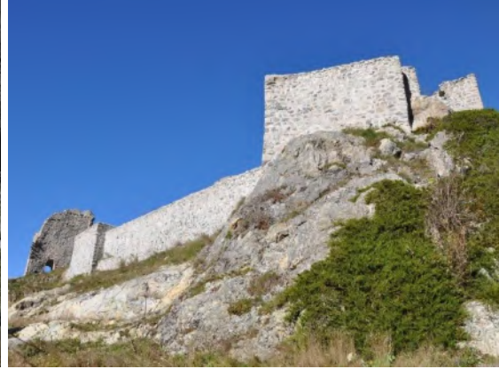
Res. 52. Batı Sur Duvarı ve Burçları
