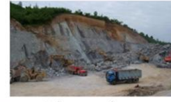
Yol yapım çalışması
