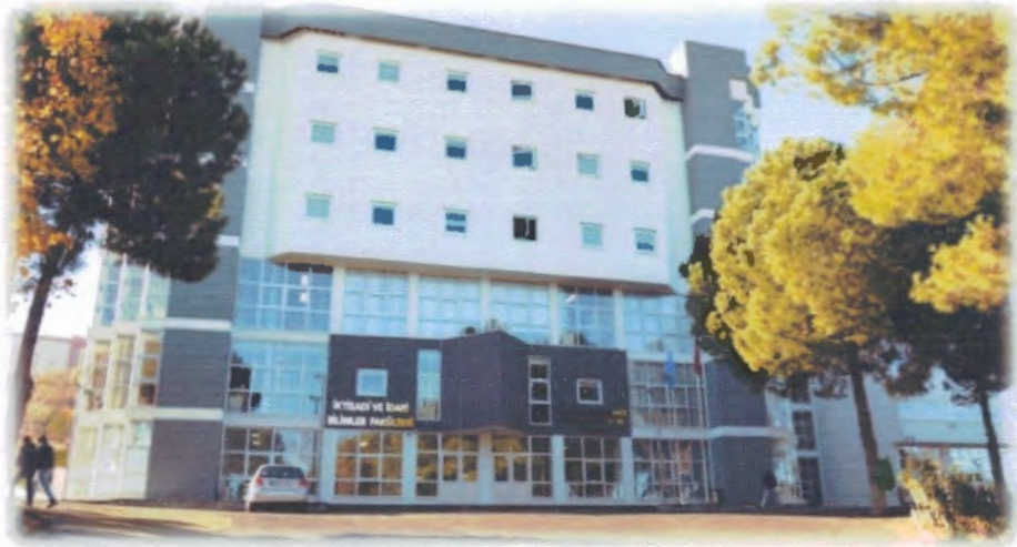
Fakülte Binası İdari Blok
