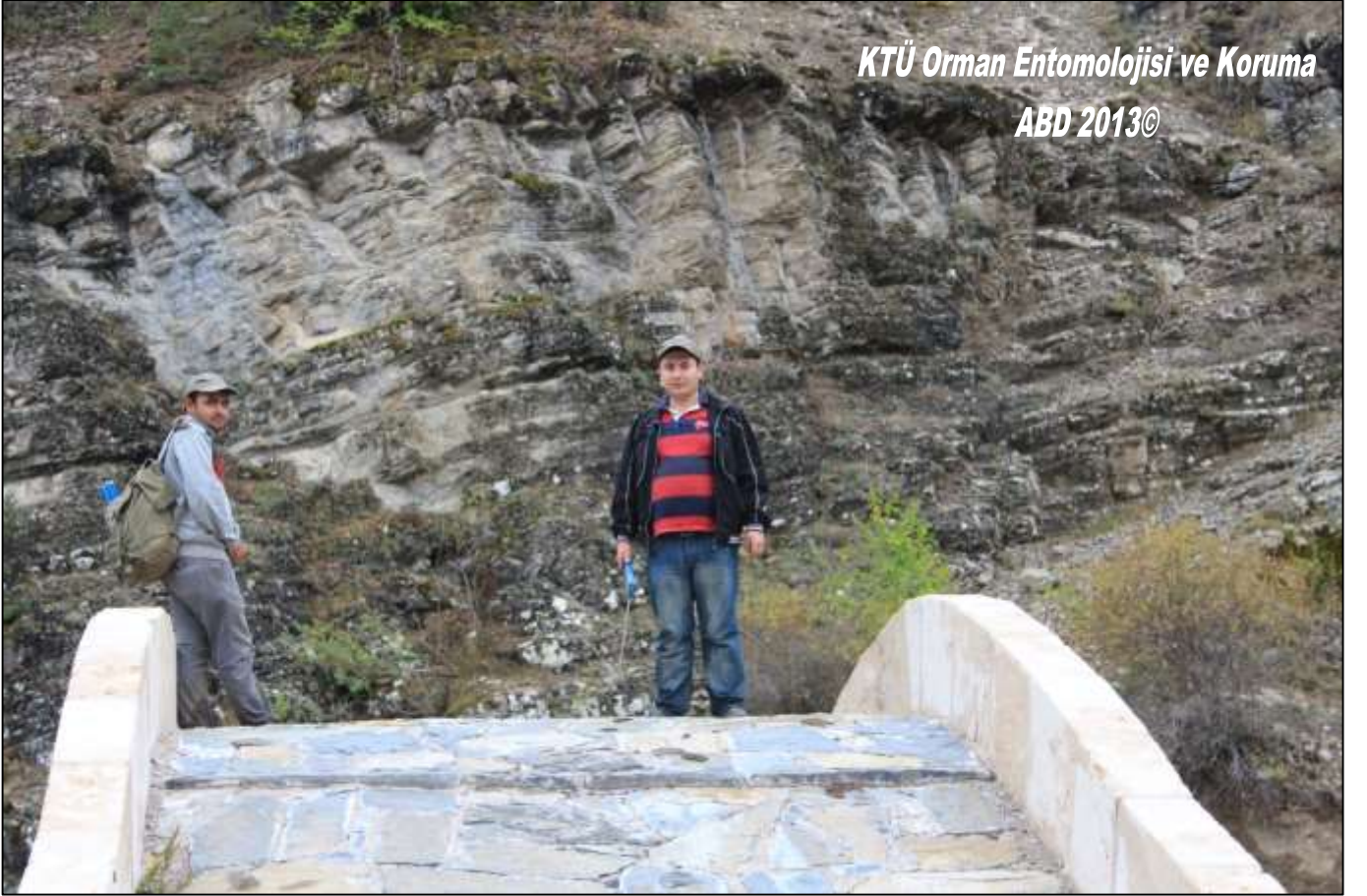
Meryem Ana Köprüsü
